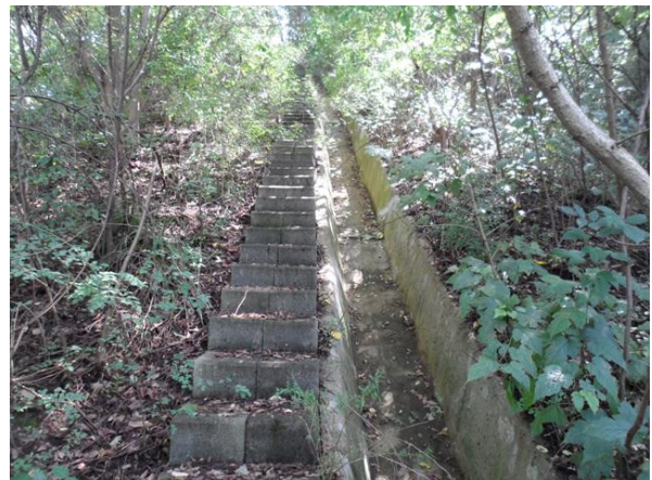
산마루측구, 점검계단 전경
