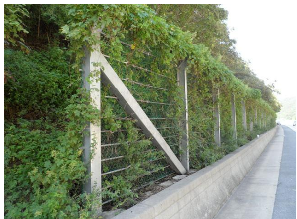
도로, 낙석방지울타리 전경
